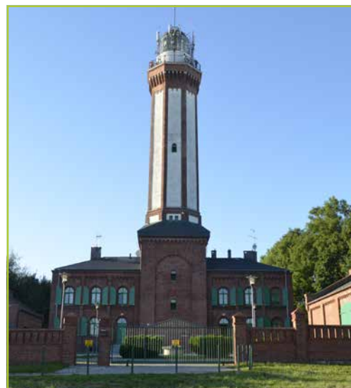
Latarnia morska w Niechorzu
